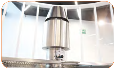
Regulador de tiro para control de temperatura.
