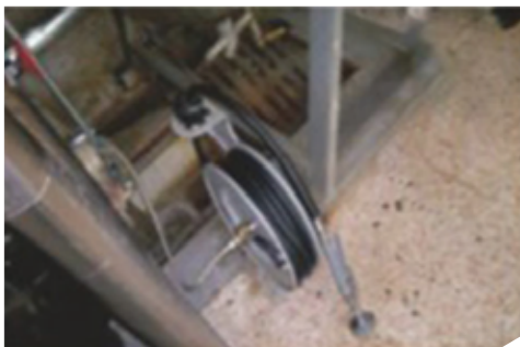
Está prohibido instalar bajo tierra para afectar a la presión del agua y la recuperación de estiramiento.
